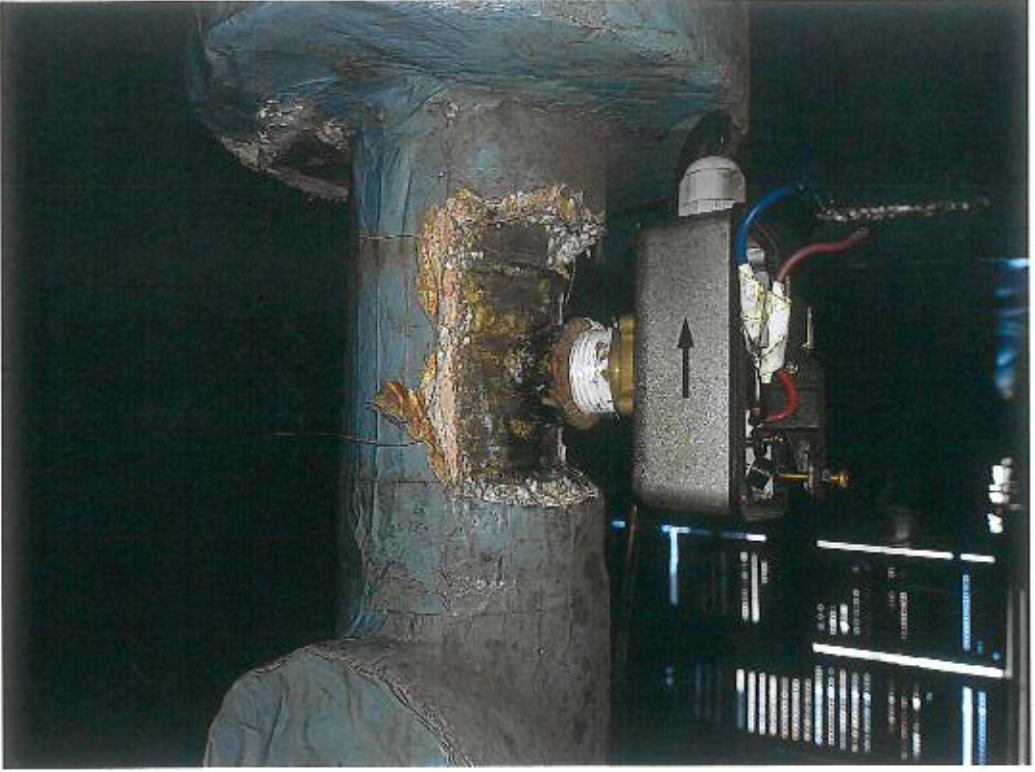
MED Physic Power switch
